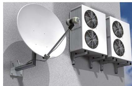
Antenne paraboliche e condizionatori
