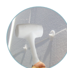
4 - Battere sullo spinotto per ottenere l'espansione
